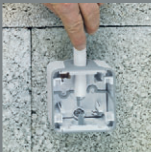
2/ Zasuňte trubku přes vytvořený otvor
