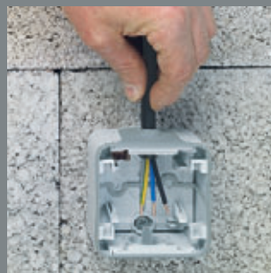
3/ Membrána zabezpečuje krytí IP 55
