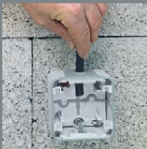
2/ Prostrčte kabel přes průchodku
