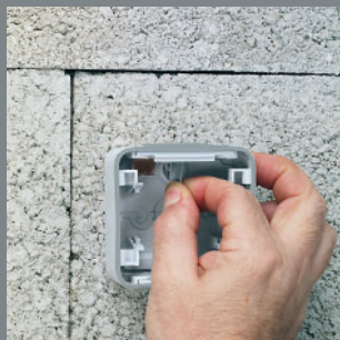
1/ Otvor uděláte zatlačením pomocí zakončovacího nástroje
