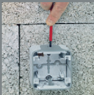
1/ Propíchněte membránu pomocí šroubováku
